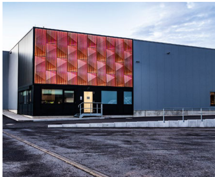
Biofassade am Firmengebäude von richter & heß
